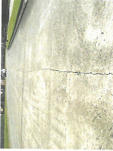
Longitudinal crack
