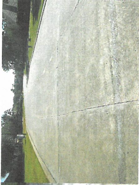
Longitudinal crack
